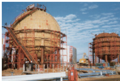
全体焼鈍（施工例）
